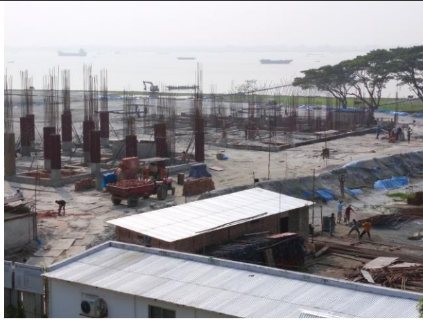
নির্মাণাধীন ম্যানেজিং ডাইরেক্টর- এর প্রশাসনিক ভবন ও অফিসার্স মেস ভবন
